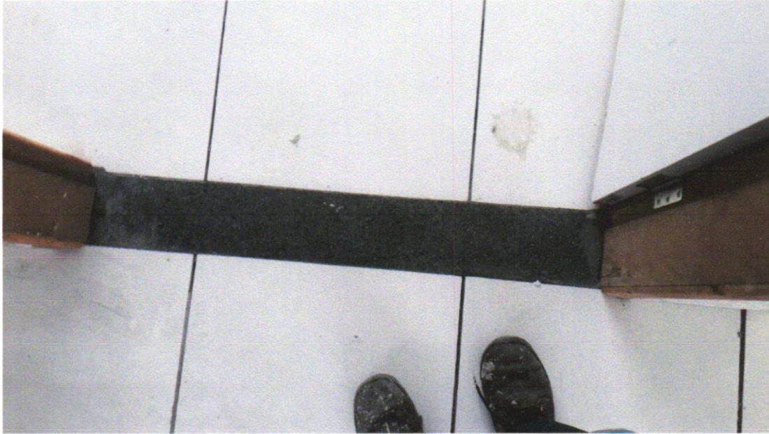
FOTO 29 -SOLEIRA EM GRANITO, LARGURA 15 CM, ESPESSURA 2,0 CM. AF_09/2020
