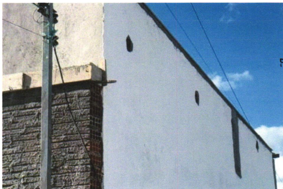
FOTO 28 - APLICAÇÃO E LIXAMENTO DE MASSA LÁTEX EM PAREDES, UMA DEMÃO.
