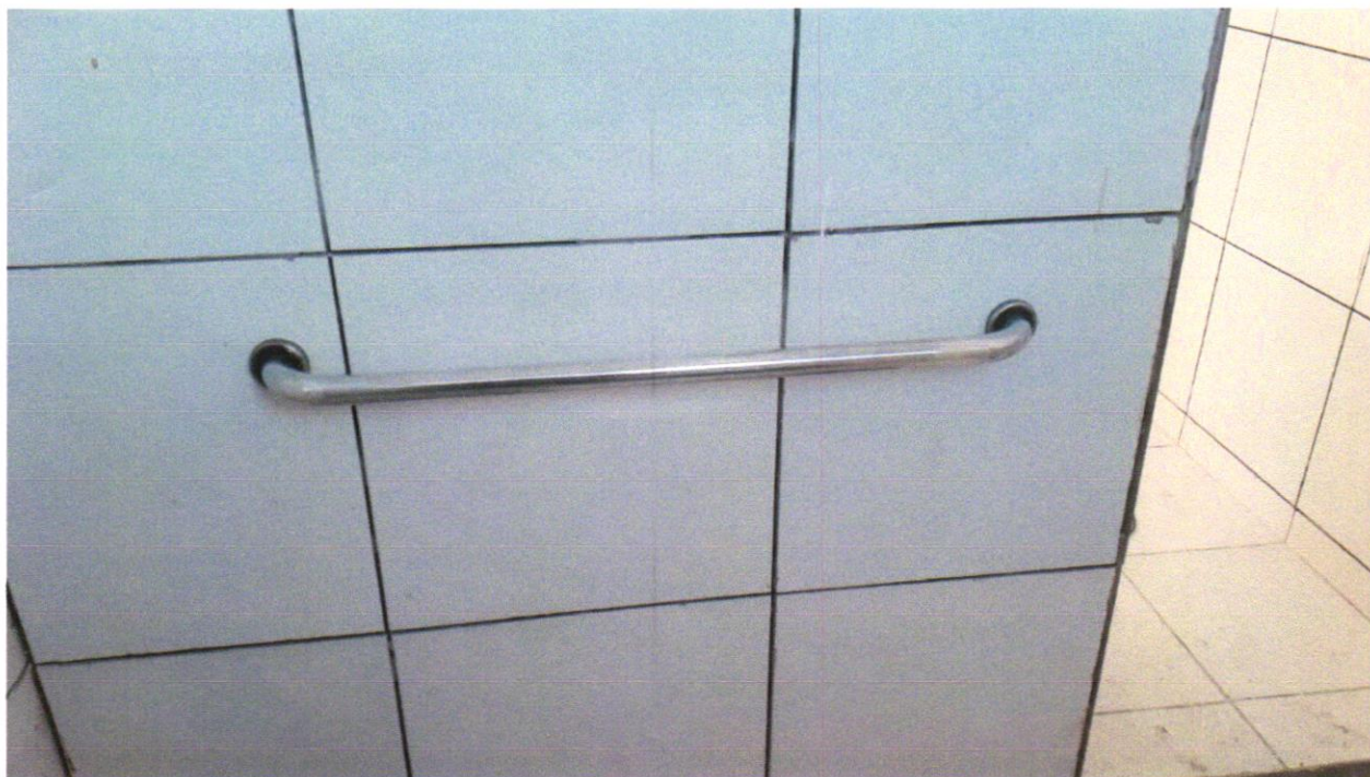
FOTO 33 -BARRA DE APOIO RETA, EM ALUMINIO, COMPRIMENTO 60 CM, FIXADA NA PAREDE - FORNECIMENTO E INSTALAÇÃO. AF_01/2020
