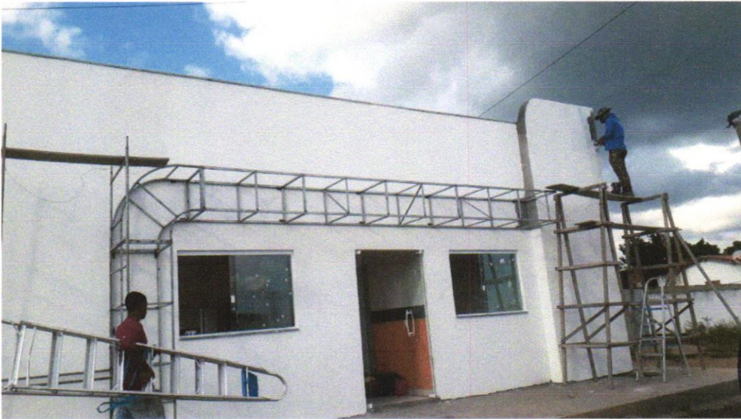
FOTO 30 - Revestimento metálico em alumínio composto (Alucobond), e=0,3mm, pintura Kaynar 500 composta por seis camadas, inclusive estrutura metálica auxiliar em perfil de viga "U" de 2" - fornecimento e montagem
