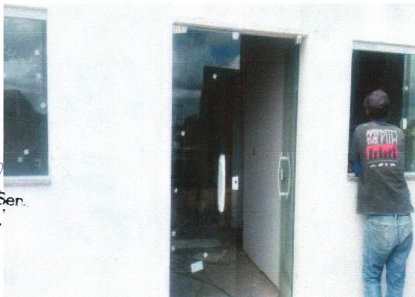
FOTO 20 - JOGO DE FERRAGENS CROMADAS PARA PORTA DE VIDRO TEMPERADO, UMA FOLHA COMPOSTO DE DOBRADICAS SUPERIOR E INFERIOR, TRINCO, FECHADURA, CONTRA FECHADURA COM CAPUCHINHO SEM MOLLA E PUXADOR. AF_01/2021
