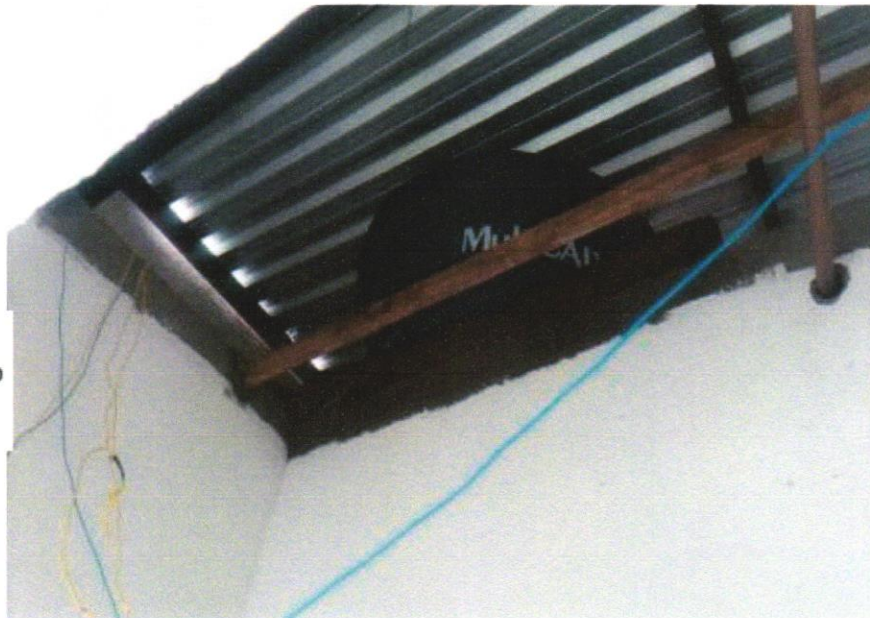
FOTO 15 - CAIXA D'ÁGUA EM POLIETILENO, 500 LITROS - FORNECIMENTO E INSTALAÇÃO. AF_06/2021
