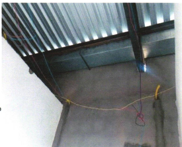
FOTO 02 – CALHA EM CHAPA DE AÇO GALVANIZADO NÚMERO 24, DESENVOLVIMENTO DE 100 CM, INCLUSO TRANSPORTE VERTICAL. AF_07/2019
