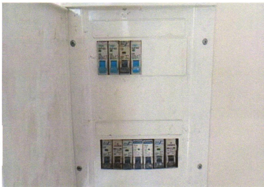
FOTO 07 - DISJUNTOR MONOPOLAR TIPO DIN, CORRENTE NOMINAL DE 10A , 20A E 25A - FORNECIMENTO E INSTALAÇÃO. AF_10/2020
