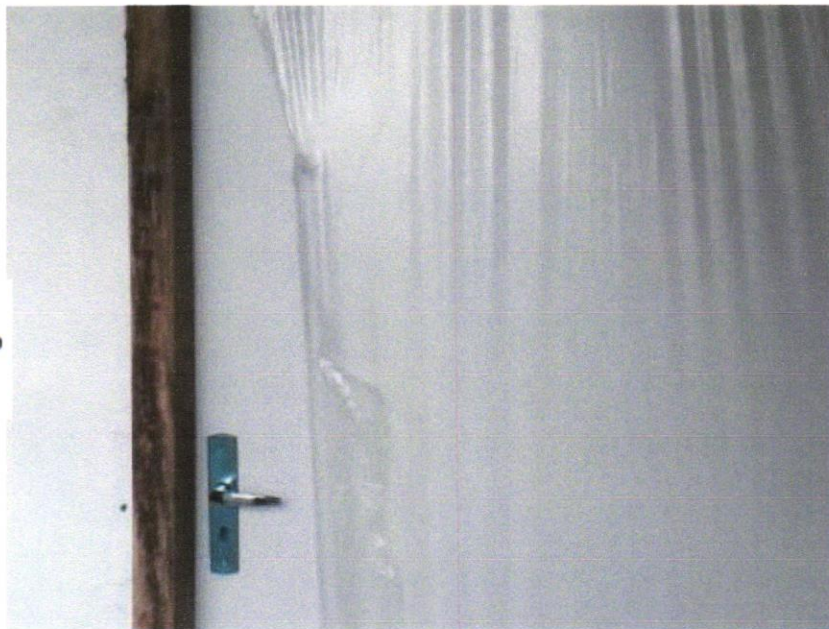
FOTO 19 - FECHADURA DE EMBUTIR PARA PORTAS INTERNAS, COMPLETA, ACABAMENTO PADRÃO MÉDIO, COM EXECUÇÃO DE FURO - FORNECIMENTO E INSTALAÇÃO. AF_12/2019
