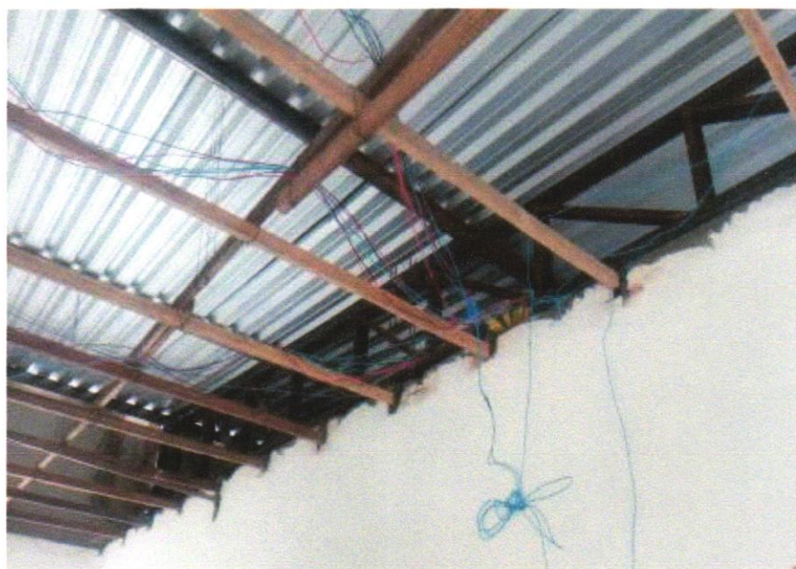
FOTO 08 – CABO DE COBRE FLEXÍVEL ISOLADO, 4 MM 2 , ANTI-CHAMA 450/750 V, PARA CIRCUITOS TERMINAIS - FORNECIMENTO E INSTALAÇÃO. AF_12/2015
